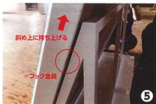
⑤仮置きした日の丸額装を、斜め上に持ち上げ、フック金具にしっかりセットしてください。
